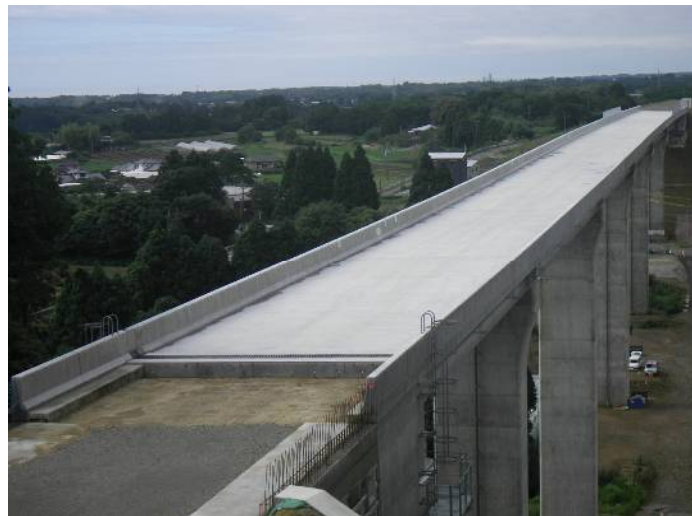
東九州自動車道 都農川橋(鋼上部工)工事
