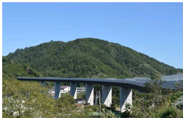
普代高架橋上部工架設工事
