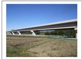
高須賀第2高架橋その1/茨城県 関東地方整備局(常総国道事務所)
