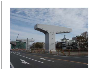
大西北1中橋脚/愛知県 中部地方整備局(愛知国道事務所)
