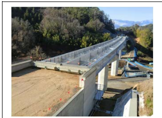
24号橋/長野県 中部地方整備局(飯田国道事務所)
