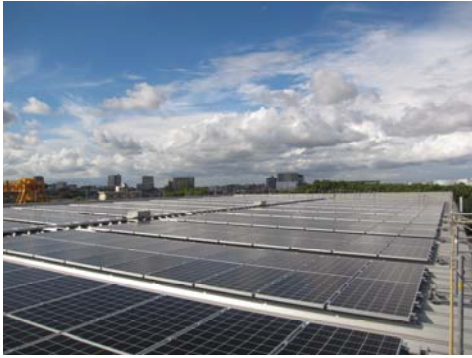
① 本社屋上
