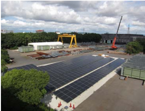
③ 旧メッキ置場
