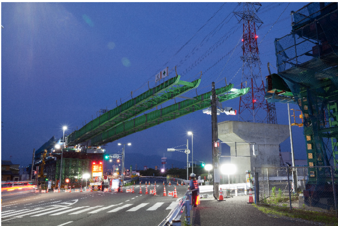
国道 21 号の上空を移動する橋桁
