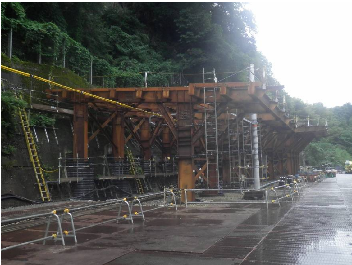
防護工工事途中状況(H29.9.27 現在)
