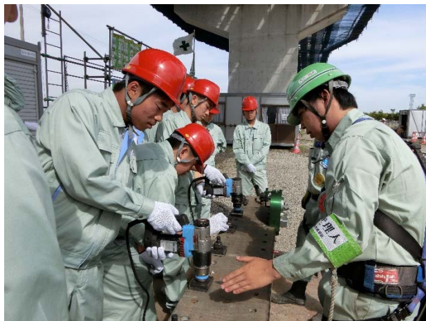
写真9 高力ボルト締め付け体験
