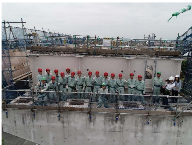
写真8 ドローン撮影（桁端部）
