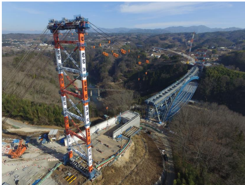
ケーブル式架設
