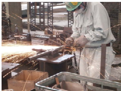
パイプの加工
