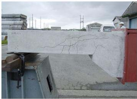
現場打ち壁高欄
