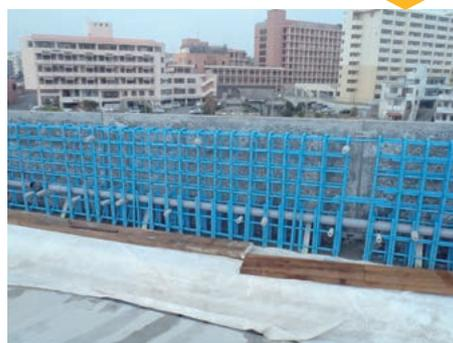
③ 壁高欄内部の鉄筋を組立てます。
