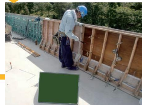
④ 内側の型枠（木製型枠）を組立てます。
