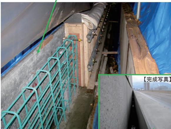
高欄の取替工事（鋼製高欄→壁高欄）の施工例
