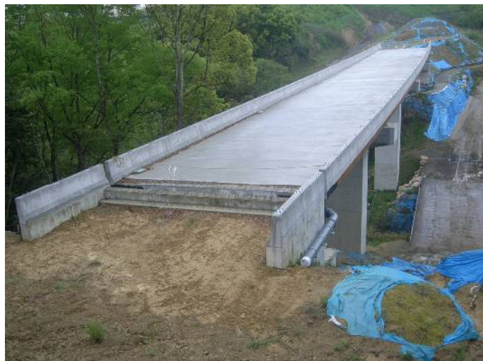
紀北東道路梅ノ木谷川橋上部工事
