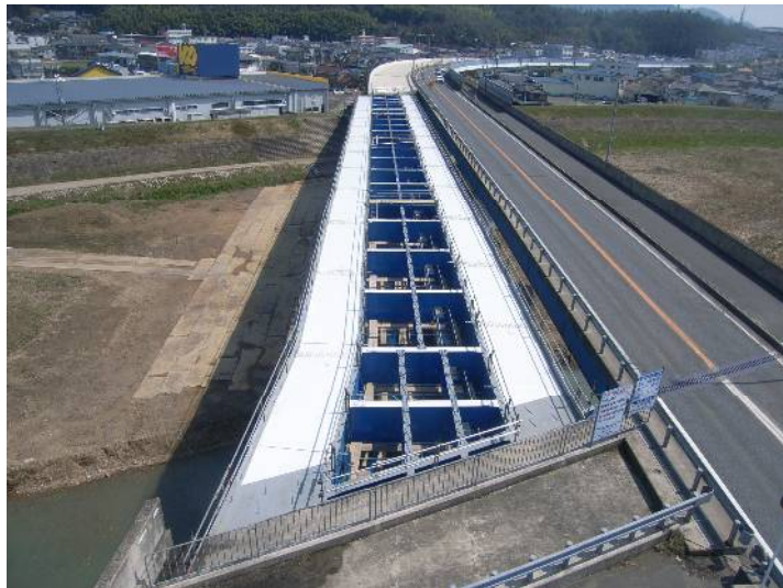
福知山道路新土師川橋鋼橋上部工事
