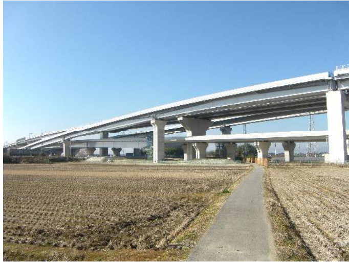
大和御所道路三宅IC橋・寺川橋鋼上部工事
