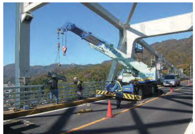
写真-8 補強部材取付け状況
