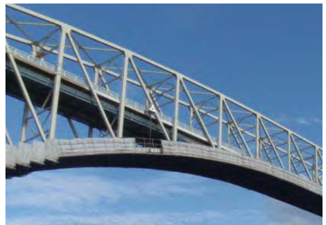
写真-7 下弦材吊足場組立完了
