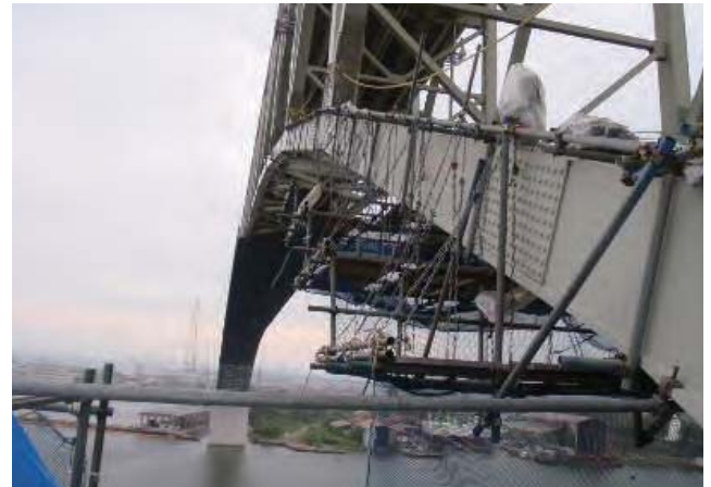
写真-6 下弦材吊足場組立状況
