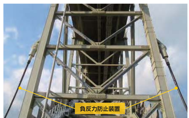
写真-5 支点上対傾構と支点部の補強(2)
