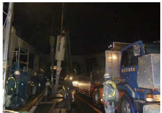
写真-11 PCケーブル取付け状況
