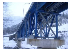
吉ヶ原橋補強/岐阜県 中部地方整備局(高山国道事務所)
