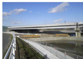
東員高架橋/三重県 中部地方整備局(北勢国道事務所)
