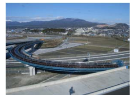
大垣西IC・Aランプ橋/岐阜県 中部地方整備局(岐阜国道事務所)
