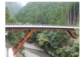
沼田原橋/奈良県 奈良県十津川村
