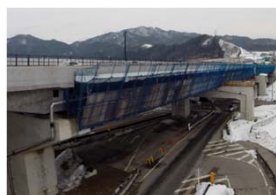
上切高架橋/岐阜県 中部地方整備局(高山国道事務所)
