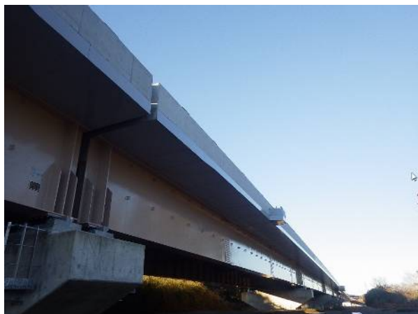
圏央道柳橋高架橋上部その1工事
