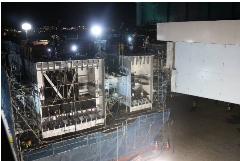
P3側仕口へ 大ブロック接近
