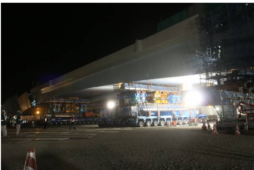
キャリアによる 架設全景
