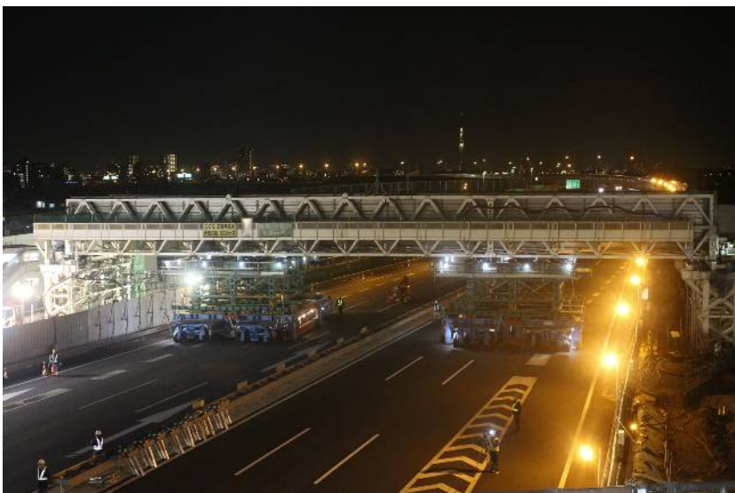
キャリア仮橋下へ セット完了
