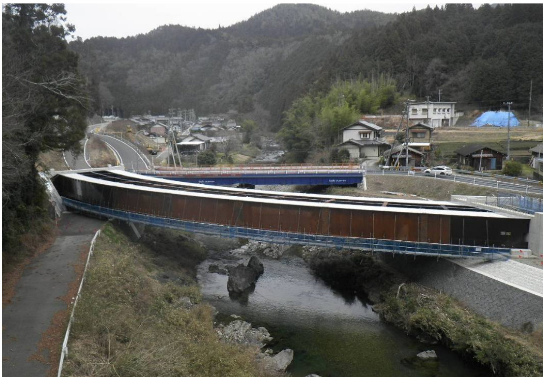
公共防災・安全交付金(債務)他(仮称)新飯高橋上部工製作・架設工事
