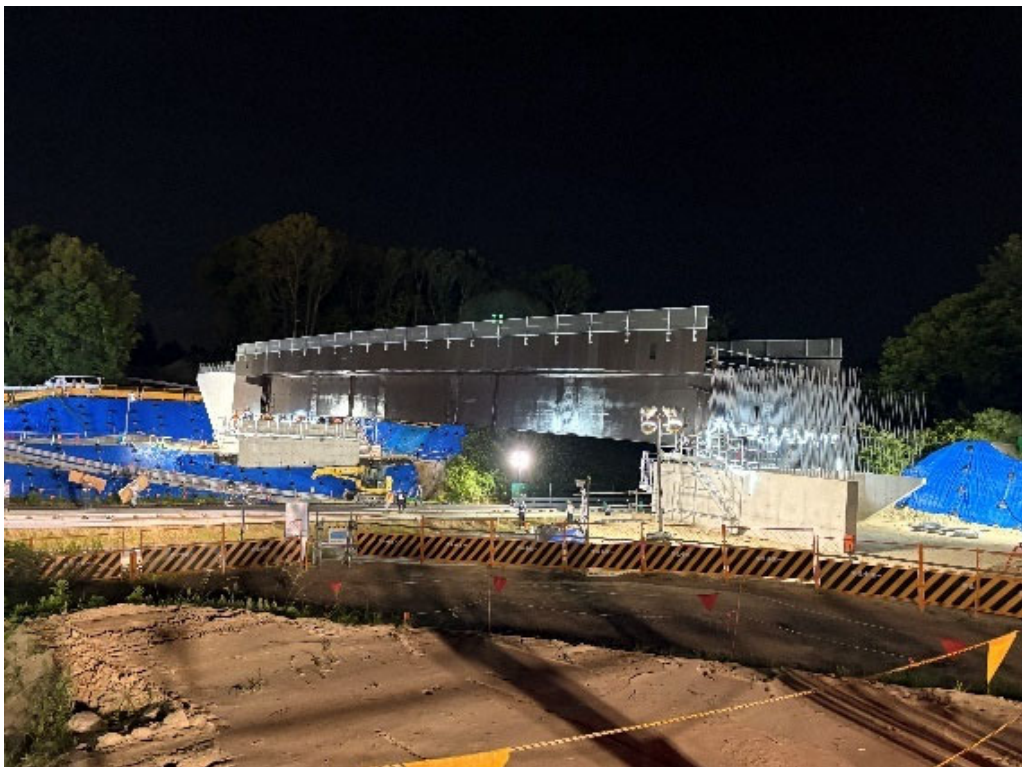
④ 架設完了
